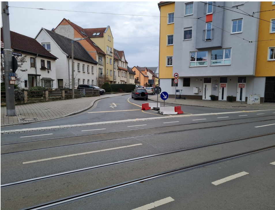
Querungshilfe für Fußgänger Einfahrt Camsdorfer Straße von Osten Karl-Liebknecht-Straße
