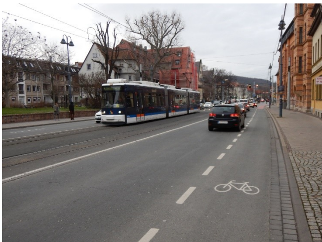
1. SCHUTZSTREIFEN AN HAUPTVERKEHRSTRASSE
